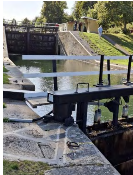
Blick in eine Schleusenammer
