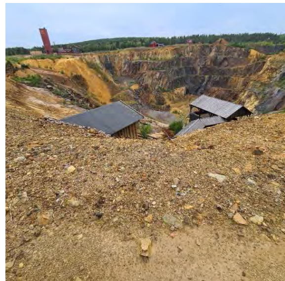
Blick in die eingestürzte Grube des Bergwerks
